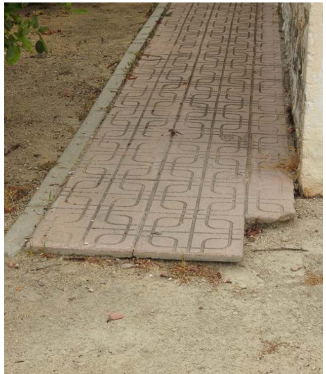
Desprendimiento de material en pavimentos exteriores
