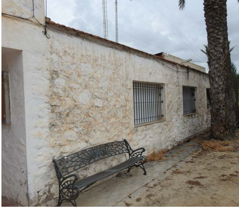
Tendidos eléctricos en fachada
