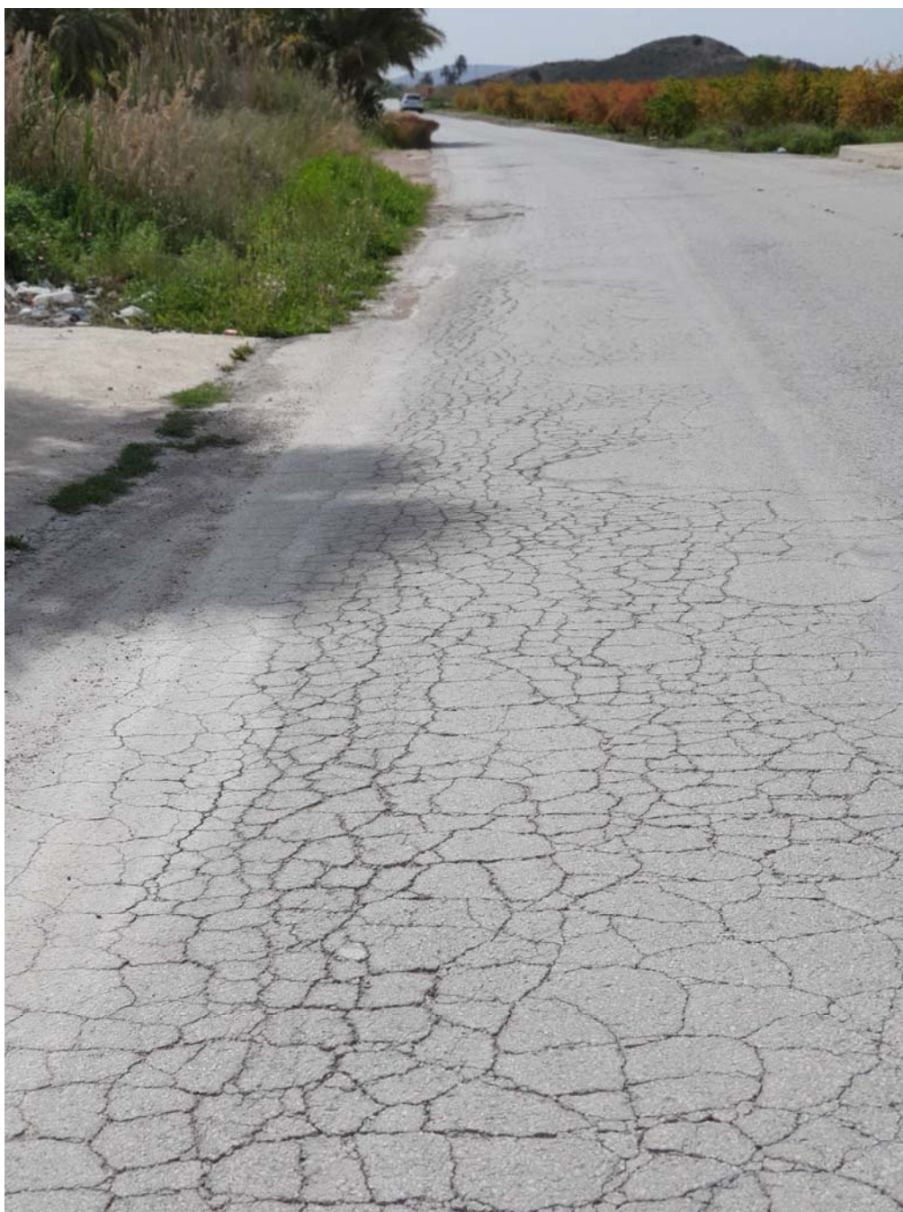
Foto 2.- Principio calle Italia polígono industrial
